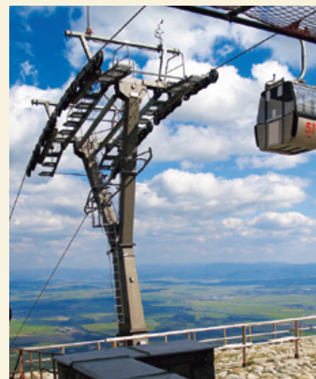
■ロープウェイの支柱、駅舎
